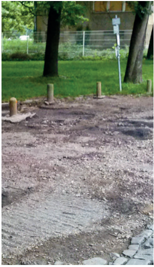
Bild 23: Nach der Saaleflut 2013: Erosion als Folge starker Strömung vom Ober- in den Unterlauf im Bereich des Zugangs zum Bernburger Rosenhag.
